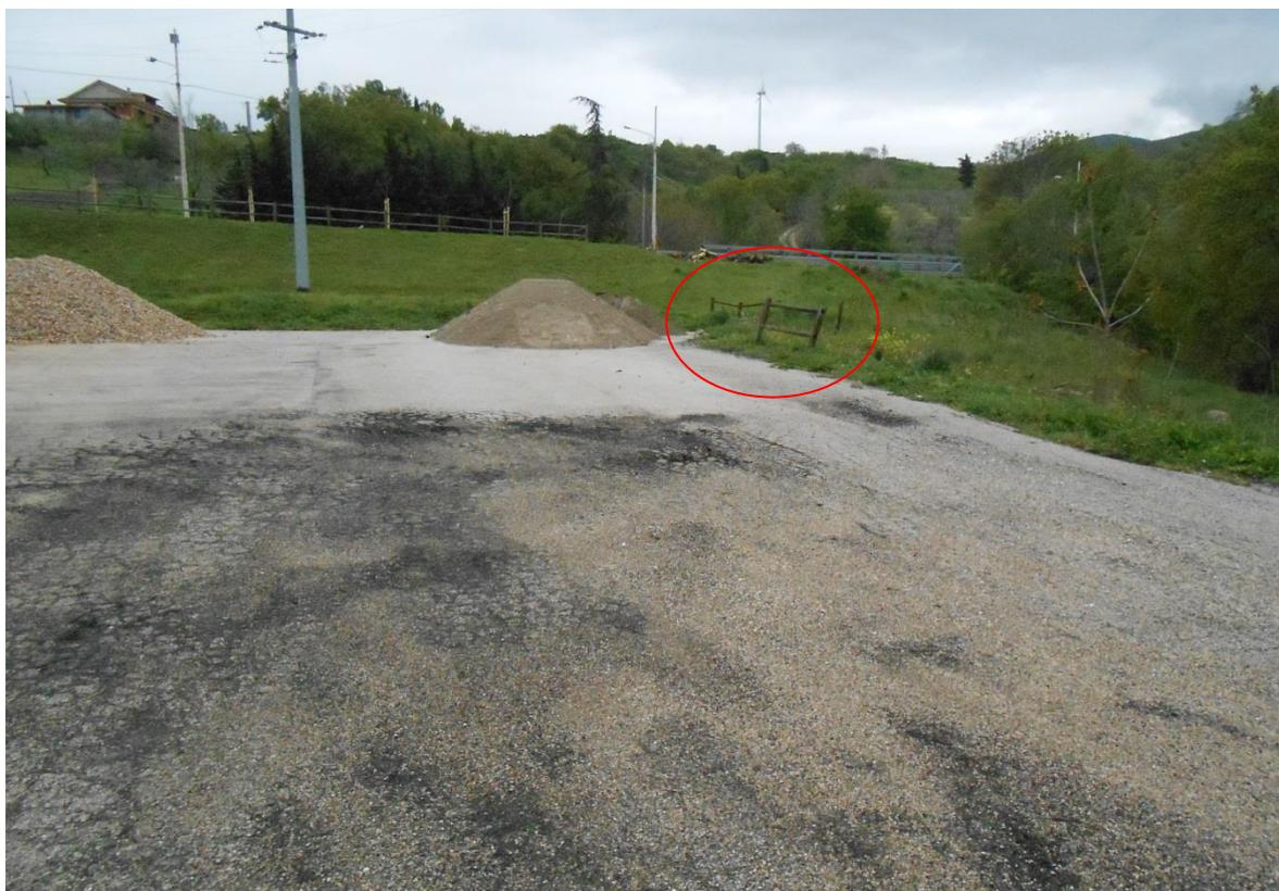
Figura 19. Smottamento Piazzale Calcare: formazione di avvallamenti e buche, palizzata inclinata
