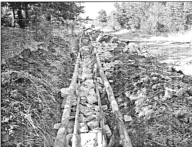
Interventi di ripristino dei sentieri con la realizzazione di staccionate in legno e di canalette in pietra e legno.
